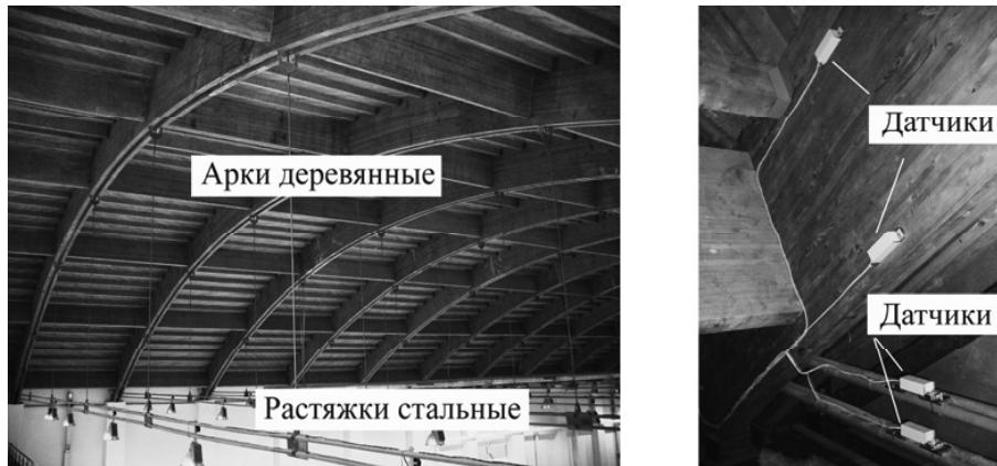
**Рис. 2. Датчики деформации в системе мониторинга спорткомплекса «Буртасы» (г. Пенза)**
