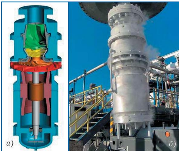
Рис. 11. Конструкция ПЖД, созданного для криогенного комплекса «Krio» (а), и его внешний вид в ходе заводских испытаний (б)
