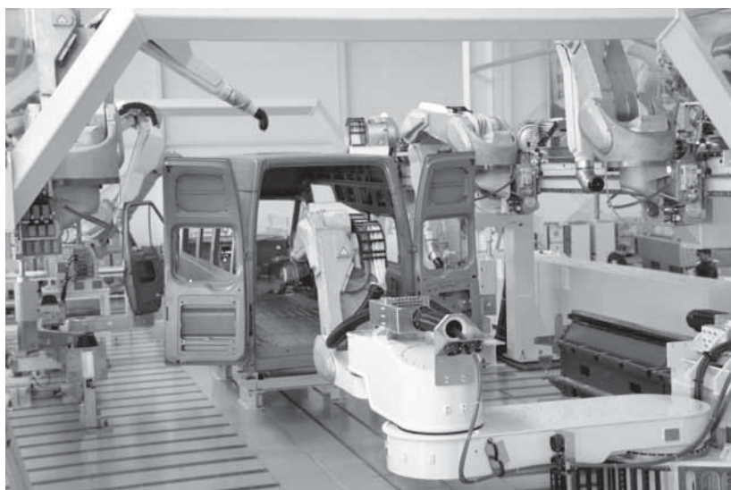
Станция во время пусконаладочных работ
