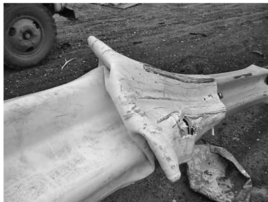
Рис. 2. Деформация металлического ограждения после наезда автомобиля
