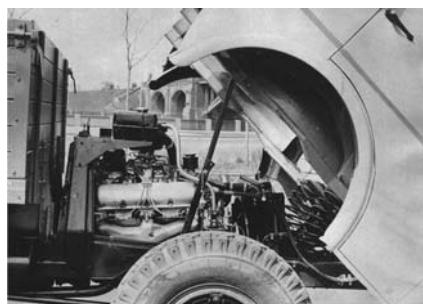
Грузовик имел откидывающуюся кабину над двигателем
