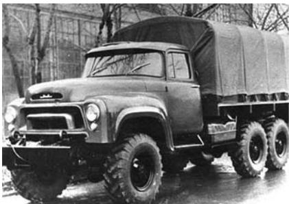
Опытный образец автомобиля ЗИЛ-165, имеющий унифицированную кабину с ЗИЛ-130
