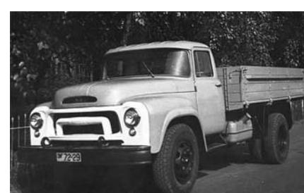
Грузовой автомобиль ЗИЛ-130 образца 1957 г. с рядным шестицилиндровым двигателем
