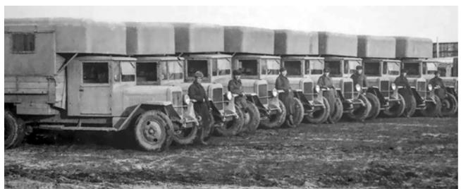
Производство УльЗИС — ремонтные летучки на шасси грузовиков ЗИС-5
