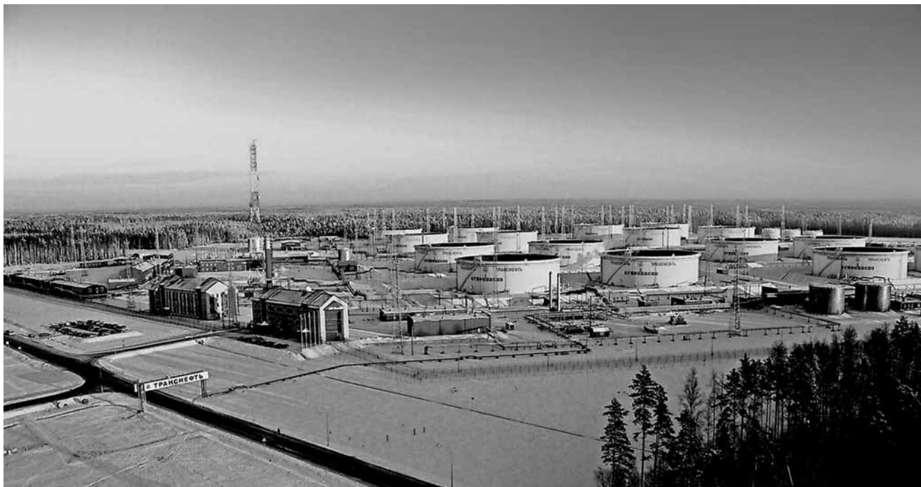
Рис. 1. Резервуарный парк хранения нефти и нефтепродуктов
