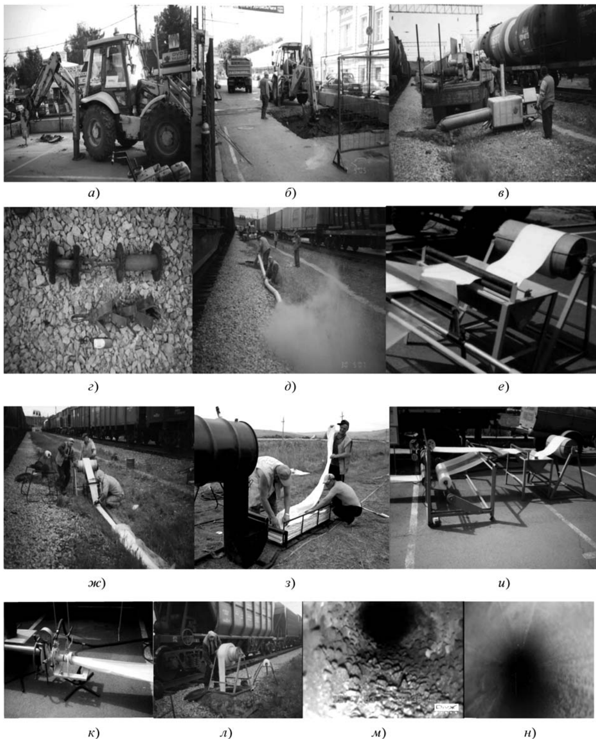
Рис. 5. Фотофрагменты выполнения операций бестраншейного ремонта трубопроводов способом комбинированного рукава: а, б – взламывание асфальта и копание грунта при устройстве приемков; в – сушка и прогрев трубопроводов; г – применяемые скребковые, щеточные и поршневые устройства для очистки трубопроводов; д – обеспыливание трубопроводов; е, ж, з – пропитка тканевых оболочек клеем в ванне, лотке и установке ускоренной пропитки под вакуумом; и – изготовление комбинированного рукава в полевых условиях; к – ввод комбинированного рукава с его выворотом и использованием пневмозатвора; л – то же, но без выворота способом протяжки через колодец; м, н – трубопровод до и после его ремонта
